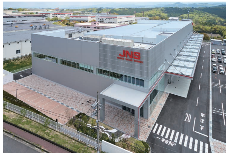
奈良第二工場
